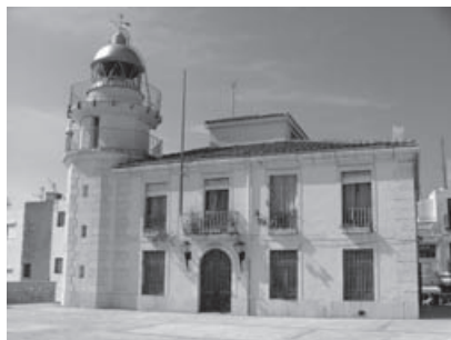
Una imatge del 2005 del far de Peníscola, deshabitat d'ençà 2013. Foto Eva Mitjà Torrent
