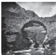
Fig. 13 - Pont gran de la vall de Núria, fotografia del MAC. Girona
