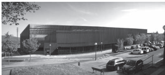
Imatge 2: Gordailua: els arquitectes han «blindat» l'edifici, metàfora del patrimoni que atesora
