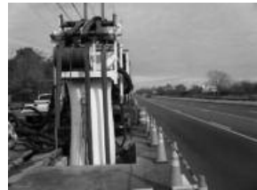
Figura 2. Rehabilitació d'una canonada per CIPP en obra. [9]
