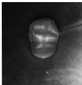
Figura 4. Mànega en procés de reversió dins la canonada amfitriona
