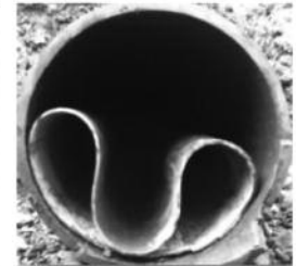
f. Col·lapse de la mànega. [11]
