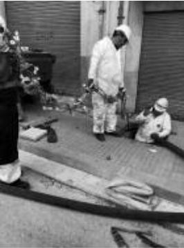
Figura 7. Introducció del carro de llums UV dins la mànega instal·lada que cal curar
