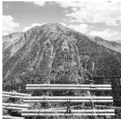
Dispositif de prévention d'avalanches au dessus de l'Hospitalet, projet SAPYRA
